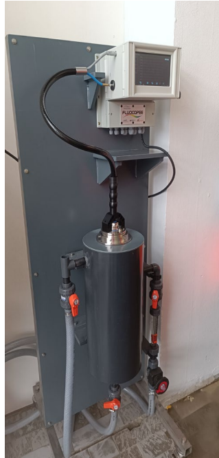
Figure 3 – Photographie du montage expérimental dans lequel sont installées les sondes Fluocopée® dans les usines du SEDIF (exemple de Choisy-le-Roi)
