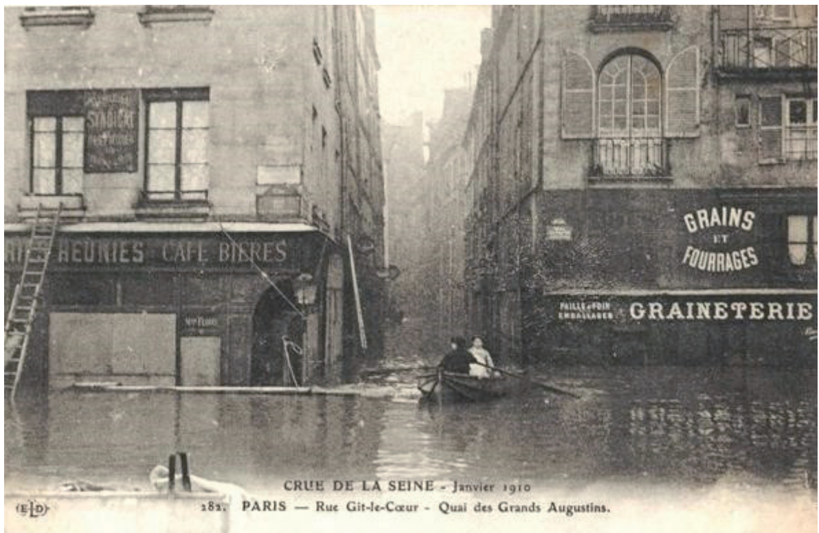
Figure 1: La crue de la Seine en janvier 1910, Quai des Grands Augustins. (DRIEE)
