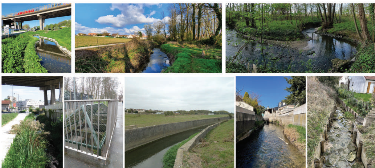
1) Bièvre réouverte à Arcueil (2022) ; 2) Morbras à Pontault-Combault (2021) ; 3) Morbras à la Queue-en-Brie (2022) ; 4) Bièvre réouverte à Gentilly (2022) ; 5) Petit Rosne couvert à Sarcelles (2020) ; 6) Petit Rosne canalisé à Ezanville (2023) ; 7) Morbras à Sucy-en-Brie (2020) ; 8) Ru de la Fontaine de Villiers à Noisieu (2021)
