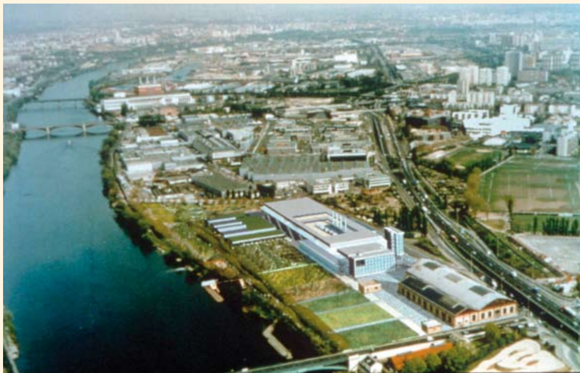
Figure 7 : Station d'épuration Seine-Centre située en rive gauche de la Seine à Colombes (Photographie : SIAAP).
