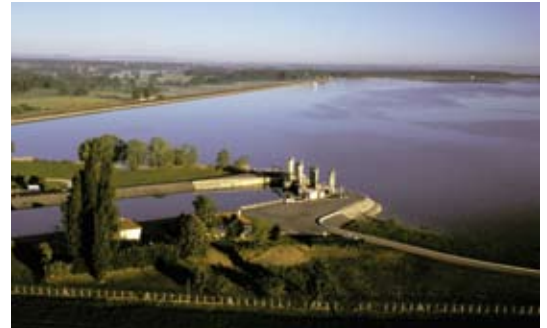
Lac Seine : déversoir d'extrémité du canal d'amenée.
