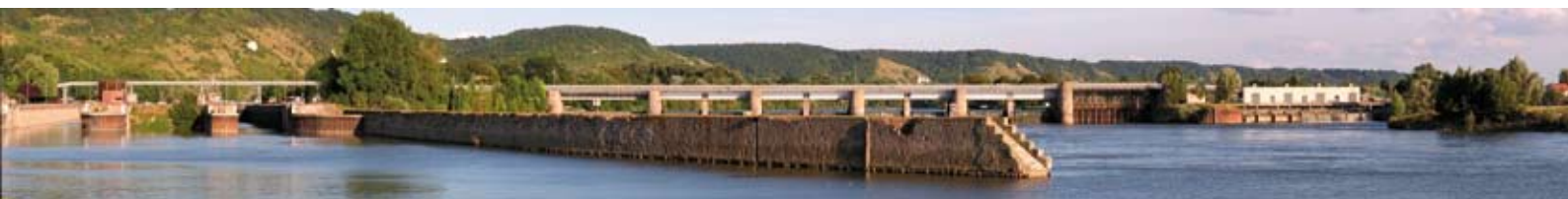
Vue panoramique du barrage de Poses (© Rodolphe Delorme).
