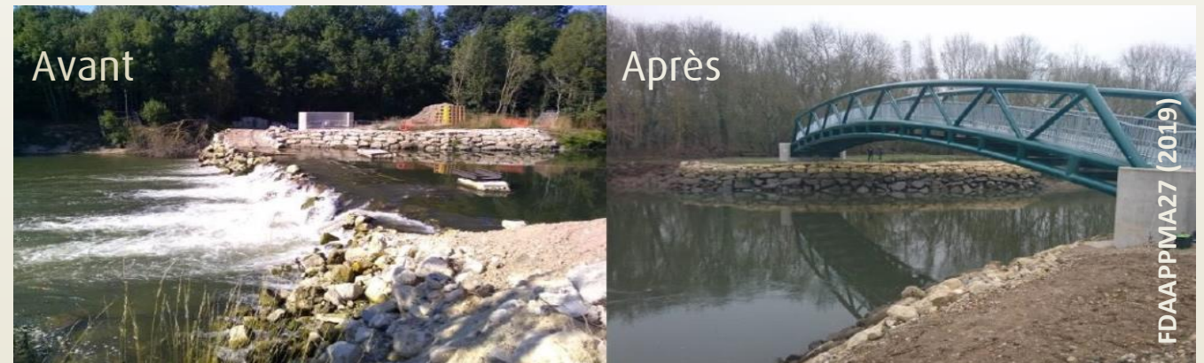
Effacement de l'ouvrage de Martot sur l'Eure
