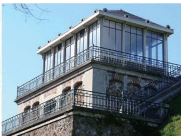
Figure 6 : Le réservoir Montsouris (Paris 14e arr.) (Source : Structurae)
