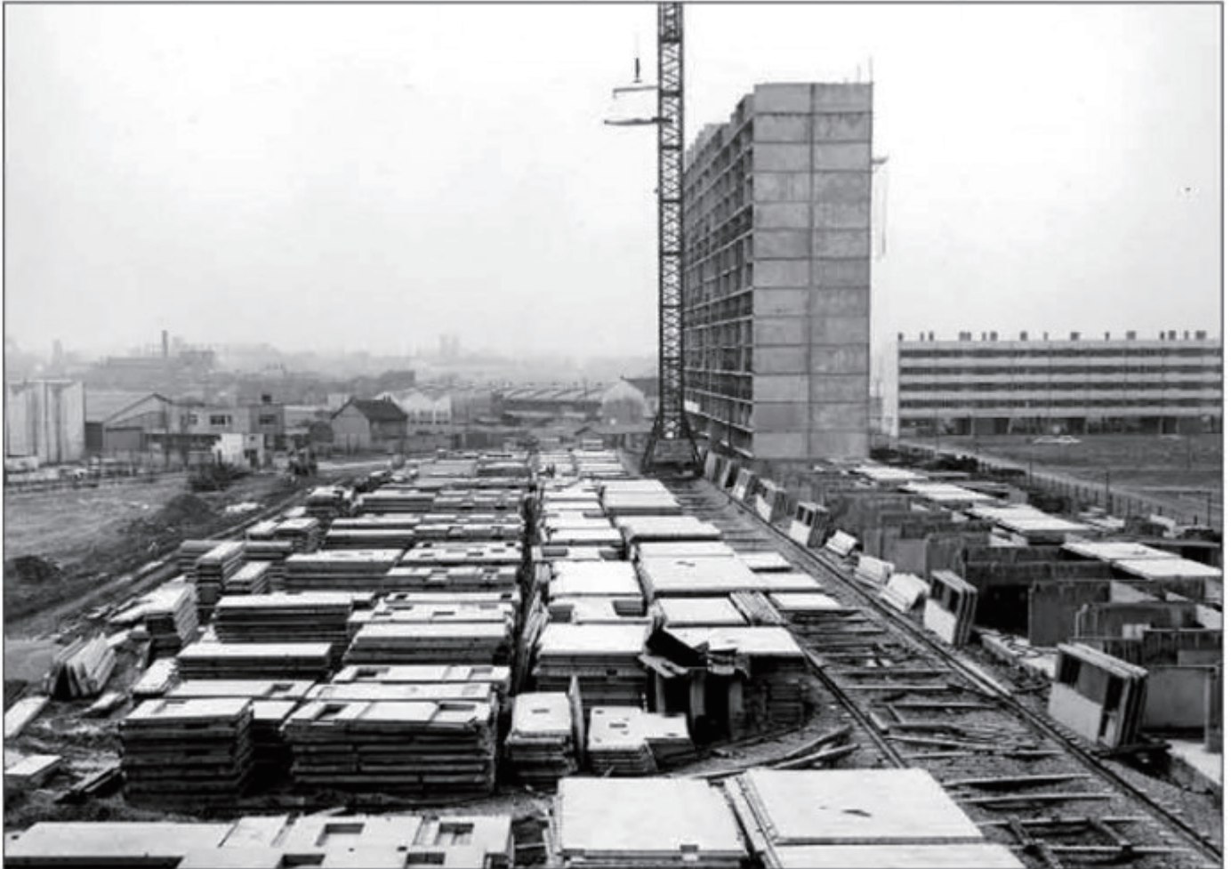
Photo 7 : Le chantier de construction des 4000 à La Courneuve (Archives municipales de la Courneuve, cité par (Fourcaut, 2012)
